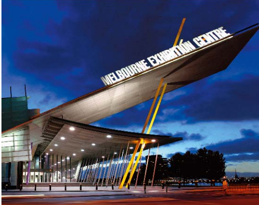
Une solution de parking SkiData a été installée au Melbourne Exhibition Center.
